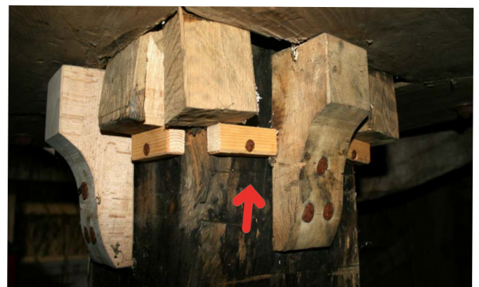
Kilerne kan også sikres med små klodser, der er sømmed under kilen. Husk at tjekke, at knagene også sidder godt fast.
